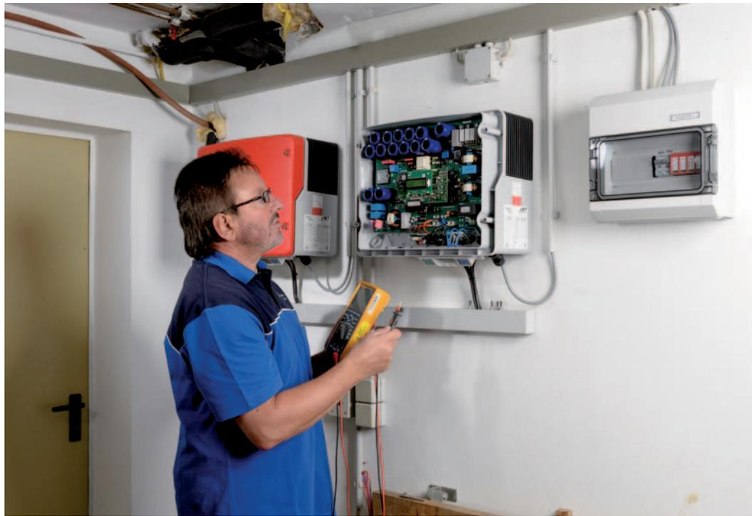
Prüfung eines Wechselrichters einer PV-Anlage in einem Einfamilienhaus.
