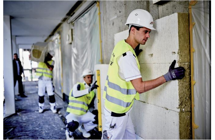
Bei der Außenwanddämmung sind alle tragenden Außenwände und Zwischendecken gut eingepackt. Es dürfen keine sogenannten Wärmebrücken entstehen, deshalb sollte die Dämmschicht möglichst lückenlos um das Gebäude verlegt werden.
