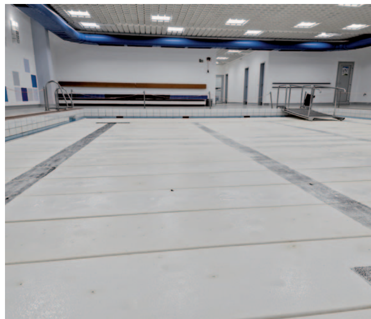
Das Lehrschwimmbecken im Hallenbad wird saniert.
