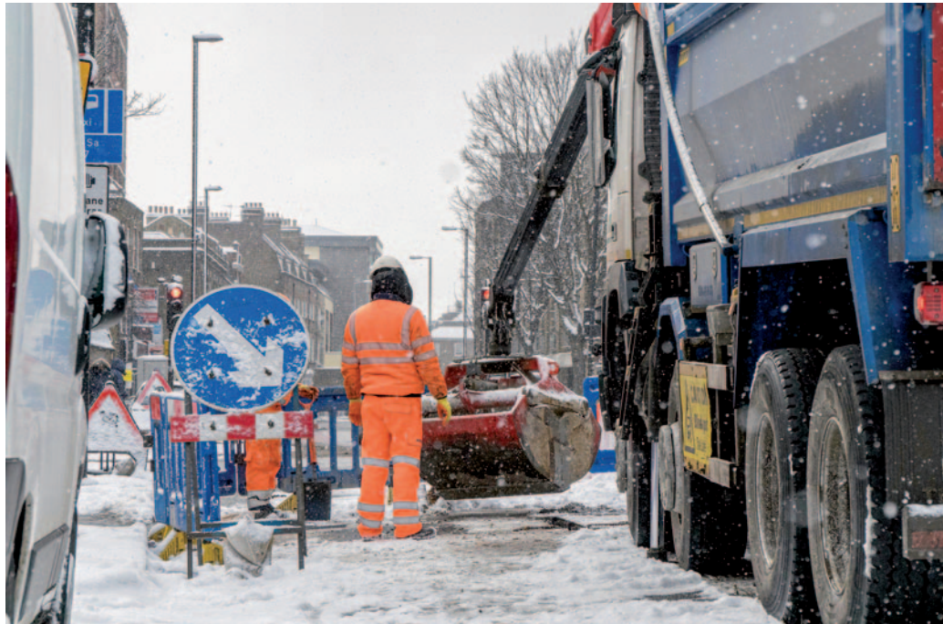
Der Winter bringt auf Baustellen besondere Herausforderungen, denn Kälte, Nässe, Glätte und Dunkelheit erhöhen die Unfallgefahr. BG BAU Berufsgenossenschaft der Bauwirtschaft/Vitalie - stock.adobe.com
