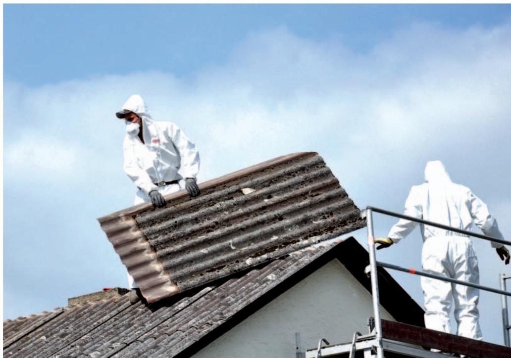
Die Sanierung asbestbelasteter Dächer muss unbedingt durch Fachleute geschehen, da das Material gesundheitsgefährdend ist und nur auf entsprechenden Deponien entsorgt werden darf. Foto: epr/Luxmetall
