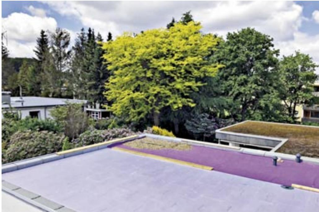
Das diffusionsoffene Dachvlies, das über der Wärmedämmung zum Einsatz kommt, wirkt lagestabilisierend und wasserableitend.
