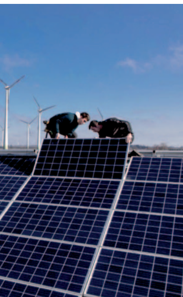
Installation einer Photovoltaikanlage für Foto: Görrissen Projekt GmbH
