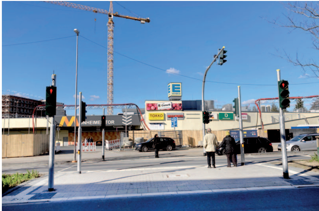
Über die neue geschaffene begrünte Verkehrsinsel geht es vom Berliner Viertel künftig direkt in den Nordeingang des Monheimer Tors, das ab dem nächsten Jahr zwei vollwertige Ein- und Ausgänge haben wird.
