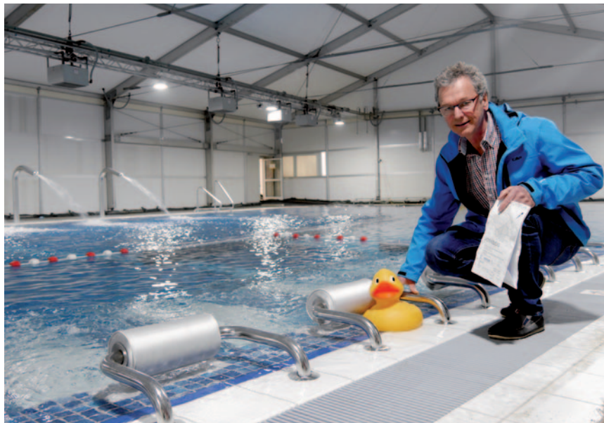
André Zierul prüft die Wassertemperatur im neuen Becken. Ein doppelwandiges beheiztes Zelt verhindert Wärmeverlust.
