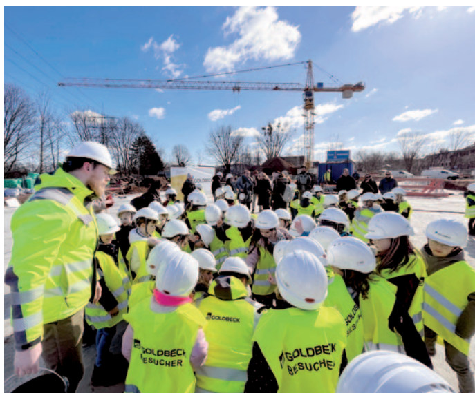
Viele fleißigere Helferinnen und Helfer gab es auf der Grundschulbaustelle an der Bregenzer Straße, in deren Fundament eine Zeitkapsel als Fundstück für nachfolgende Generationen eingelassen wurde.
