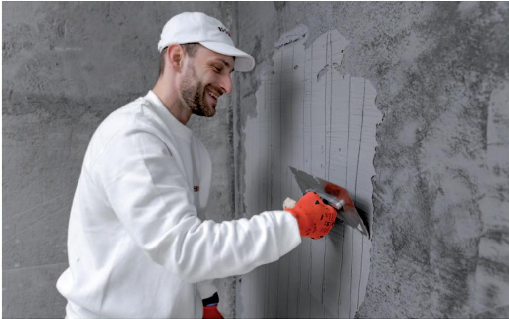
Ein Handwerker trägt eine mehrschichtige Innenabdichtung auf, um das Gebäude nachhaltig vor Feuchtigkeit zu schützen. Eine Dränanlage kann Wasser gezielt ableiten, aber sie ersetzt keine intakte Gebäudeabdichtung.
