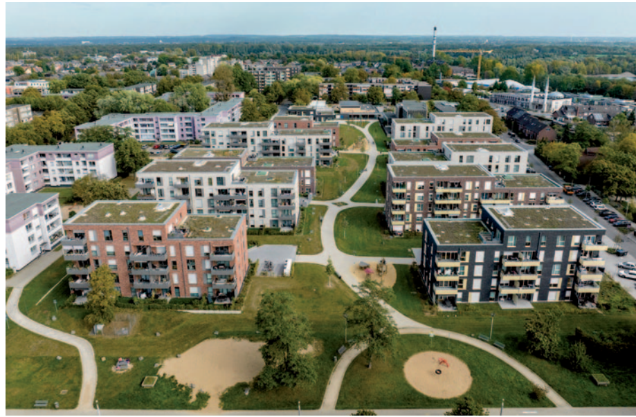
Das Wohnquartier wurde auf einem 2,2 Hektar großen Areal realisiert und weist insgesamt 232 Wohneinheiten auf.
